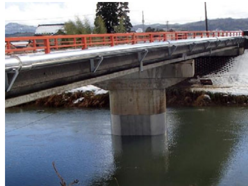
橋脚への施工事例
