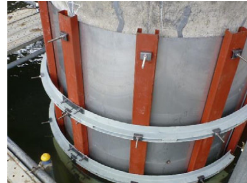
SUS型枠の組み立て
