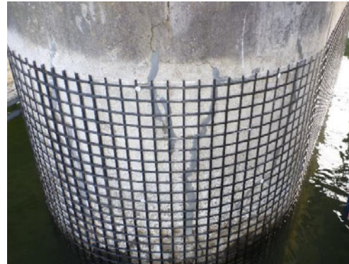
炭素繊維グリッドの設置
