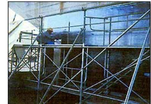
橋脚耐震補強
