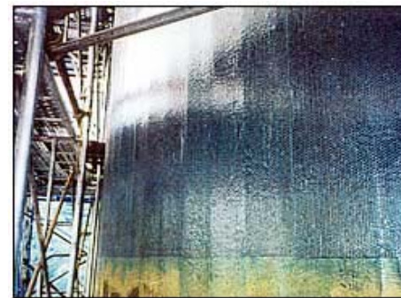
煙突劣化補強
