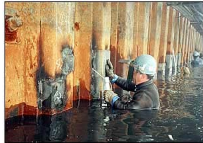
水中・気中溶接
