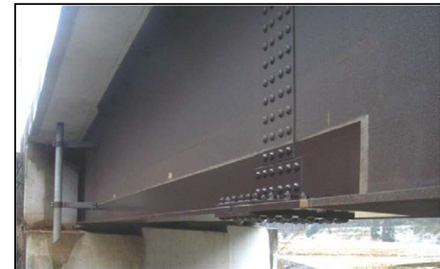
補修(部分)塗装完成
