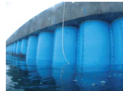
鋼管矢板への施工例
