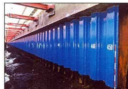
鋼矢板への施工例
