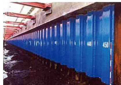
鋼矢板への施工例
