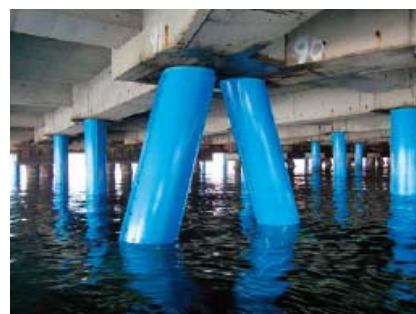
鋼管杭への施工例
