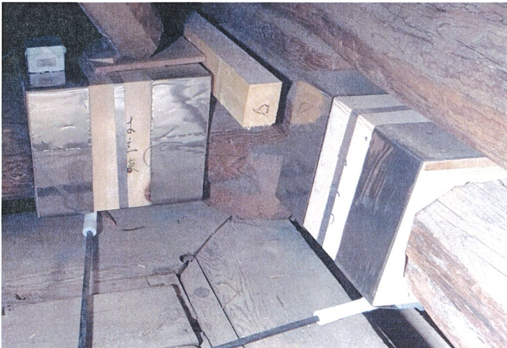
チタン箱の施工の様子
