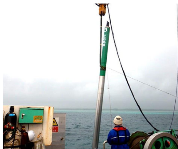
小浜航路第三号灯標の設置の様子
