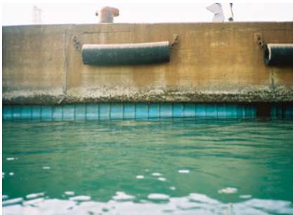
岸壁鋼矢板への施工例
