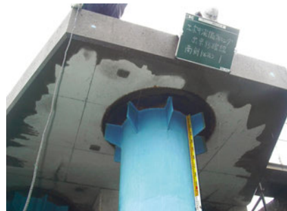
棧橋鋼管杭への施工例
