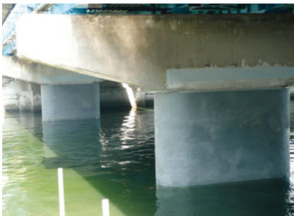
橋梁基礎への施工例
