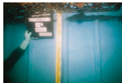
防食被覆完了
