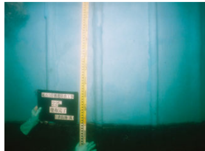
鋼矢板被覆状況(水中)
