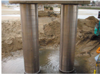
基礎鋼管杭への施工例
