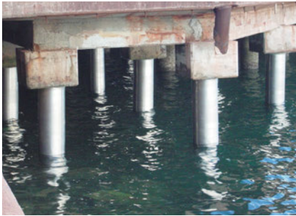
栈橋鋼管杭への施工例
