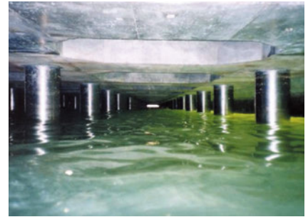
栈橋鋼管杭への施工例
