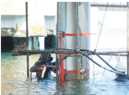
栈橋鋼管杭への施工例 (気中・水中とも溶接施工可能)
