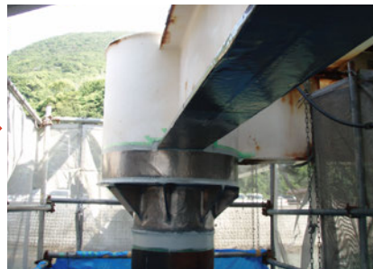
チタン箔シート貼り付け
