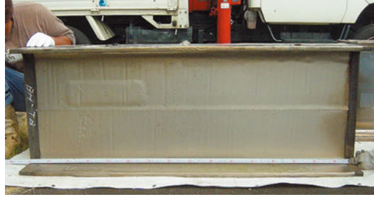
12年経過後の試験体状況 (チタン箔シート剥離前)
