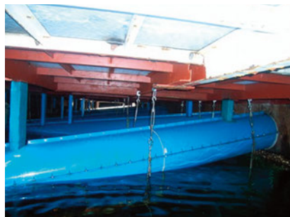
栈橋繋ぎ梁の施工例
