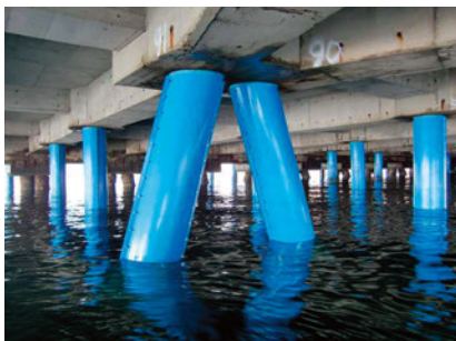
鋼管杭の施工例
