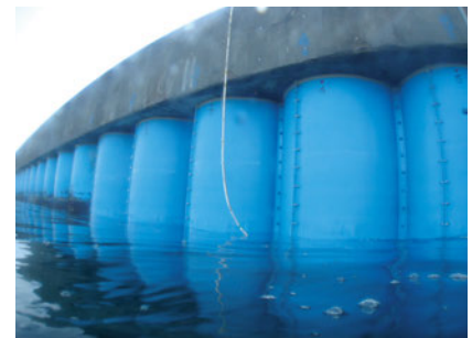
鋼管矢板の施工例
