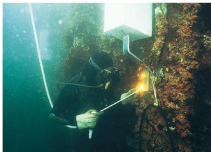
陽極の取付状況
