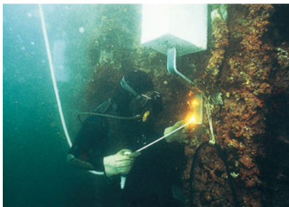
陽極の取付状況
